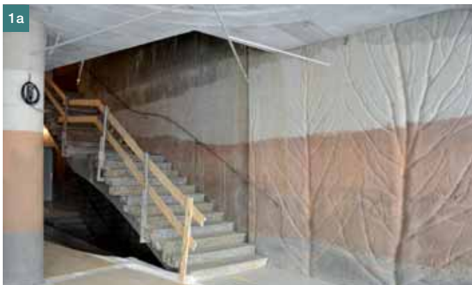
Obr. 1 Palác Národní v Praze: a) barevný vodopád v 1. NP (černý, hnědý, cihlový a bílý pigment), b) schodiště (stupně schodů s černým pigmentem a stěny z betonu s bílým cementem)
