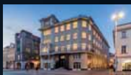
Stavební úpravy Galerie moderního umění v Hradci Králové
