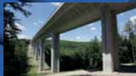
Viadukty přes údolí potoka Hrabynka a údolí potoka Kremlice
