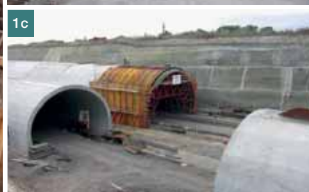
Obr. 3 Čelní stěna stanice metra: a) před betonáží finálního ostění, b) skládání bednění pro finální stěnu, c) zabetonováno
