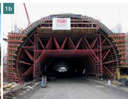
Obr. 1 Hloubený tunel: a) tunelový propustek na dálnici D3, b) pojízdňá bednicí forma ze systémových prvků pro hloubený tunel, c) postup výstavby hloubeného tunelu
