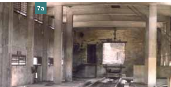
Obr. 7 Objekt E4 – prostor v 3. NP: a) původní kolejště vlečky zauhlování kotleny, stav před rekonstrukcí, 2013, b) prostor po rekonstrukci – interiér společnosti BSH ■ Fig. 7 E4 object – space on the 3rd above-ground floor: a) original railroad of the factory coal-transporting train, before reconstruction, 2013, b) after reconstruction – interior of the BSH company
