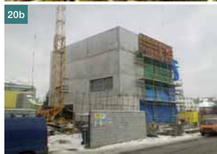
Obr. 20 a) Výstavba obvodové nosné stěny, b) dokončování předsazené betonové stěny ■ Fig. 20 a) Constructing the peripheral load bearing wall, b) finishing the concrete shaft wall
