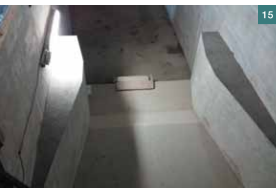
Obr. 15 Betonová konstrukce Parshallův žlab ■ Fig. 15 Concrete structure of Parshall's flume
