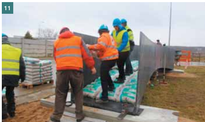
Obr. 11 Provádění statické zatěžovací zkoušky na lávce č. 1 ■ Fig. 11 Load bearing test of the footbridge No. 1
