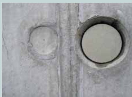
Obr. 3 Různé způsoby uzavření spínacích otvorů
