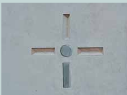
Obr. 2 Pláště bednění a jejich otisky na povrchu betonu – prkna s drážkou
