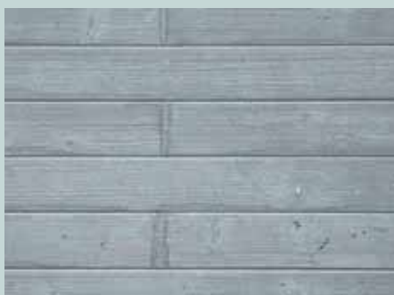
Obr. 2 Pláště bednění a jejich otisky na povrchu betonu – prkna s drážkou
