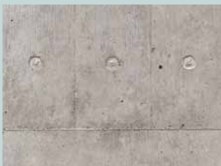
Obr. 4 Upevnění pláště bednění z pohledové strany u nosíkového nebo atypického bednění
