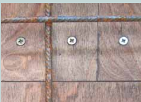
Obr. 4 Upevnění pláště bednění z pohledové strany u nosíkového nebo atypického bednění
