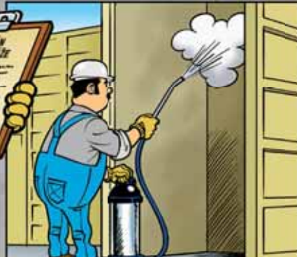
Odformovací nátěr nanese v tenké a rovnoměrné vrstvě.
