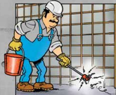
Vyčisti bednění (vysavačem, magnetem).
