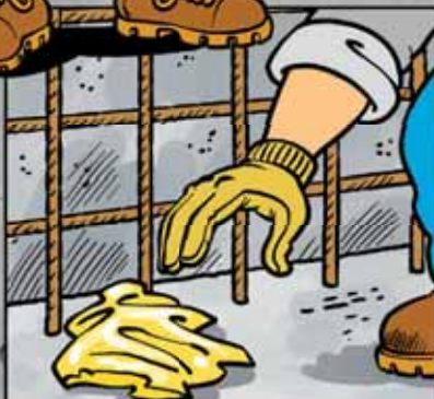
Odstraň všechny nečistoty a smetí z bednění.
