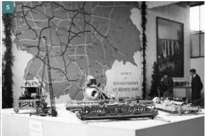
4 Vkládání mřížoviny do spodní vrstvy CB vozovky; na snímku zachyceno betonování dálniční vozovky po polovinách (zdroj: Betonstrassenbau in Deutschland, ročník 1939) 5 Model sestavy finišerů značky Dingler pro pokládku CB vozovek (zdroj: archiv autora) | 4 Inserting the ladder into the bottom layer of the cement-concrete carriageways; in the picture, there is to be seen concreting of the highway carriageway in half by half (source: Betonstrassenbau in Deutschland, Vol. 1939) 5 Model of the set of Dingler finishers used for laying the cement-concrete carriageways (source: archive of Tomáš Janda)
