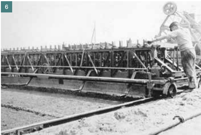
4 Vkládání mřížoviny do spodní vrstvy CB vozovky; na snímku zachyceno betonování dálniční vozovky po polovinách (zdroj: Betonstrassenbau in Deutschland, ročník 1939) 5 Model sestavy finišerů značky Dingler pro pokládku CB vozovek (zdroj: archiv autora) | 4 Inserting the ladder into the bottom layer of the cement-concrete carriageways; in the picture, there is to be seen concreting of the highway carriageway in half by half (source: Betonstrassenbau in Deutschland, Vol. 1939) 5 Model of the set of Dingler finishers used for laying the cement-concrete carriageways (source: archive of Tomáš Janda)
