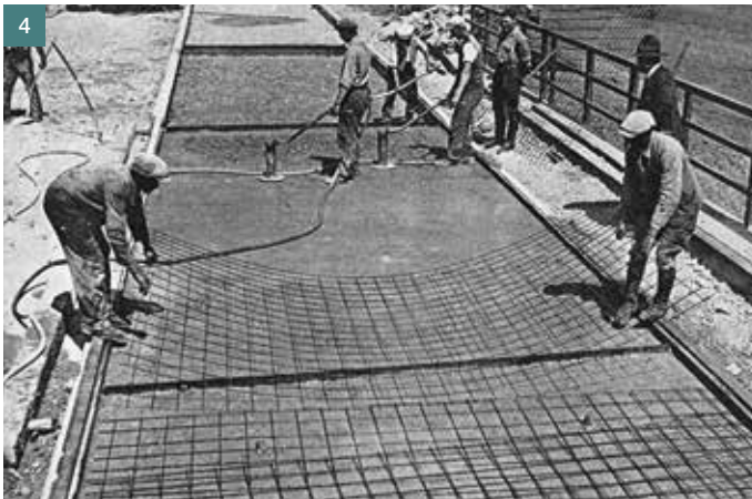
4 Vkládání mřížoviny do spodní vrstvy CB vozovky; na snímku zachyceno betonování dálniční vozovky po polovinách (zdroj: Betonstrassenbau in Deutschland, ročník 1939) 5 Model sestavy finišerů značky Dingler pro pokládku CB vozovek (zdroj: archiv autora) | 4 Inserting the ladder into the bottom layer of the cement-concrete carriageways; in the picture, there is to be seen concreting of the highway carriageway in half by half (source: Betonstrassenbau in Deutschland, Vol. 1939) 5 Model of the set of Dingler finishers used for laying the cement-concrete carriageways (source: archive of Tomáš Janda)
